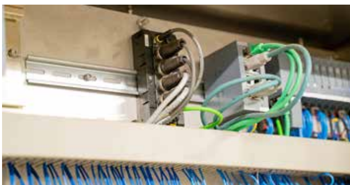
De multi-protocol I/O-module TBEN-S2-4IOL met vier IO-Link ingangen dient als interface tussen de sensoren en de PLC.
